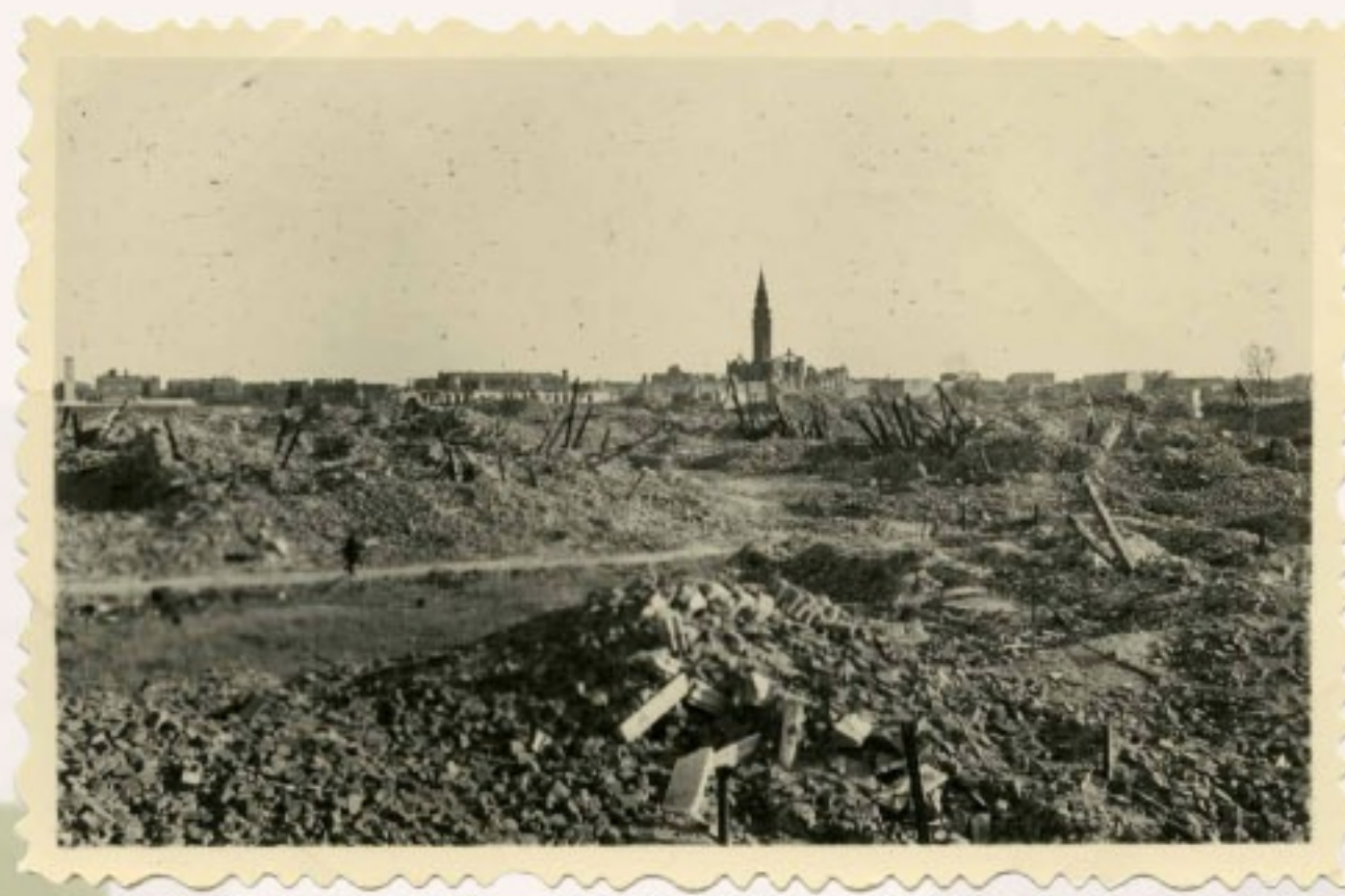
Widok zburzonej Warszawy, okolice Muranowa, 1944, APW, 1945, 30
