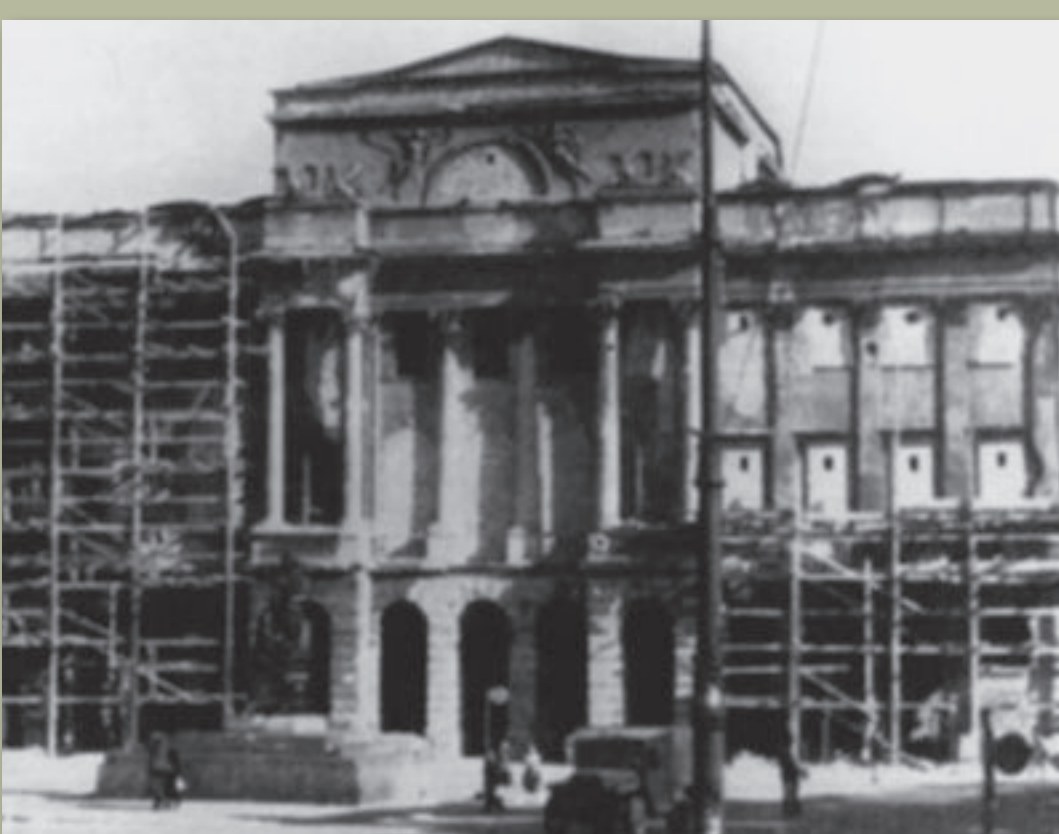
Pałac Staszica po 2. wojnie światowej, główna fasada w czasie robót rekonstrukcyjnych, 1947, APAN, Zbiór Fotografii, XXXI-39
