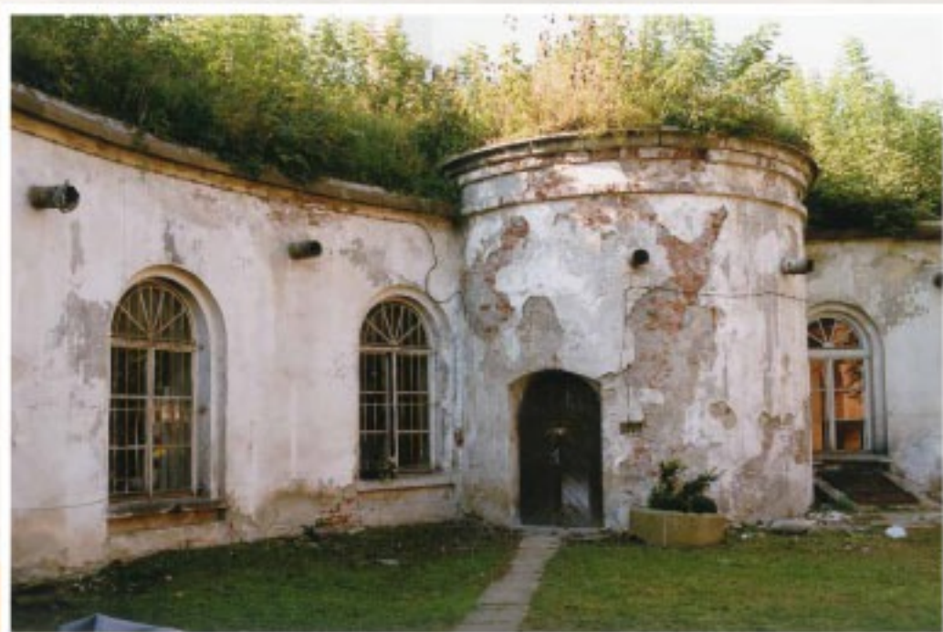
Fort Sokolnickiego na Żoliborzu, siedziba AAN w latach 1919–1951, 2008, AAN, fot. Janusz Chrzanowski
