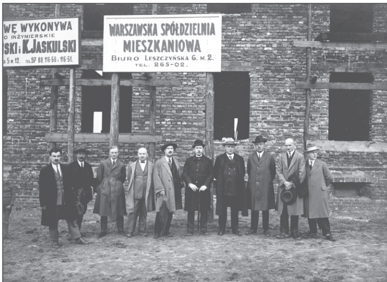
Budowa osiedla WSM na Żoliborzu, 1927, Materiały Stanisława Tołwińskiego, APAN, III-185, j. 72, k. 13
