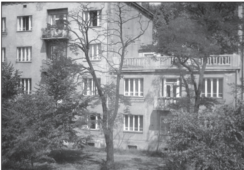
Budynek od strony wiaduktu przy ul. Mickiewicza 12, w którym mieścił się Internat nr 2; 3 okna na parterze i 2 na 1. piętrze (częściowo zasłonięte drzewami) należały do Internatu nr 2; widoczne okno na parterze to okno „różowej” sypialni, poniżej były piwnice, przy których ustawiana była w skrzyniach amunicja, 1983, Archiwum Stanisławy Żubr-Boguszowej
